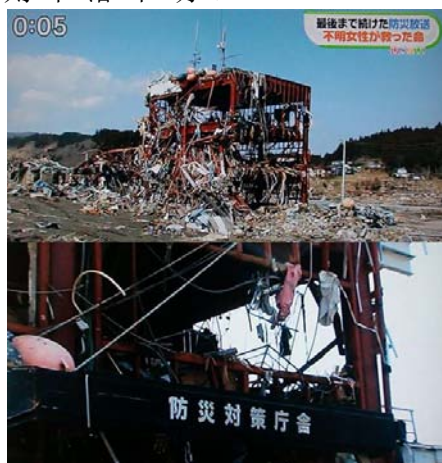
海啸冲击后的防灾对策大楼
